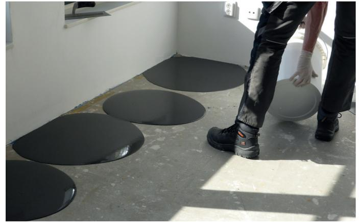
Ausgleichs benötigen. Der Raum, in dem Sie arbeiten, muss gut belüftet sein. Vor dem Auftragen des FloorColouring-Niveaus muss der Untergrund immer mit 044-1 Europrimer Multi Plus grundiert werden. Dies gewährleistet eine optimale Haftung und verhindert die Bildung von Luftlöchern in der Verlaufsschicht.
